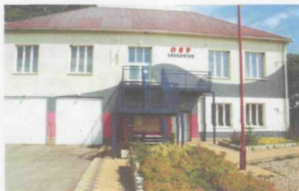
Fot. 7 Zmodernizowany budynek OS w Luszowicach wraz z urządzonym terenem zieleni.
