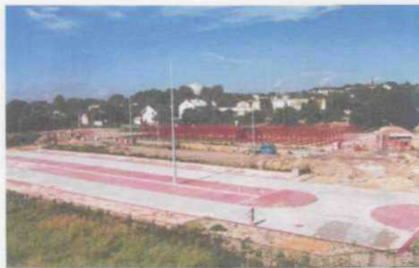
Fot. 13 Budowa targowiska miejskiego przy ul. Szpitalnej w Chrzanowie.
