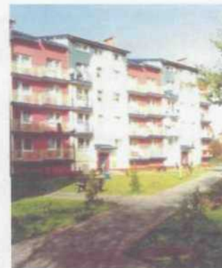
Fot. 17 Budynek Towarzystwa Budownictwa Społecznego przy ul. Jordana w Chrzanowie.
