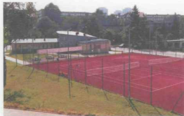
Fot. 12 Budynek gastronomiczno-szatniowy przy kortach tenisowych - os. Młodości.
